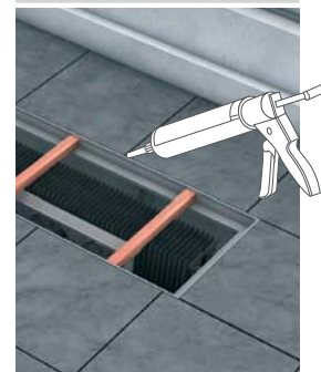
Rooster plaatsen / Emplacements de la grille / Rost einlegen / Place the grille
